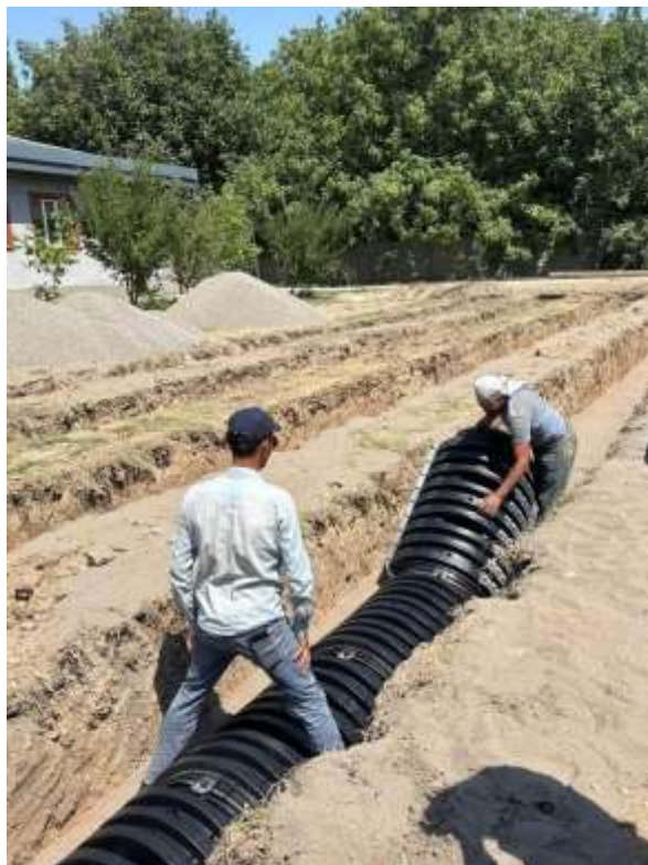
PILOT LOYIHA "Soakaway" infiltratsiya maydonini yotqizish
